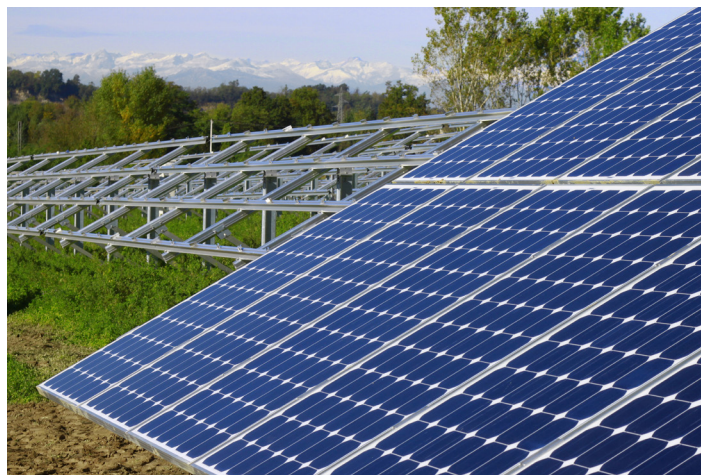
Staalconstructie voor PV-systemen
